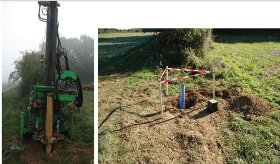
**Figure 3.16 : Atelier de forage (à gauche) et mise en place du tubage et du capot ras de sol (à droite)**
